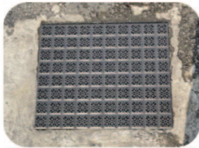
그레이팅 규격에 맞게 안전덮개 위치를 잡고 올려놓는다
