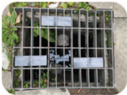
소켓 위치가 한 부분에 치우치지 않게 교차·분산하여 설치한다
