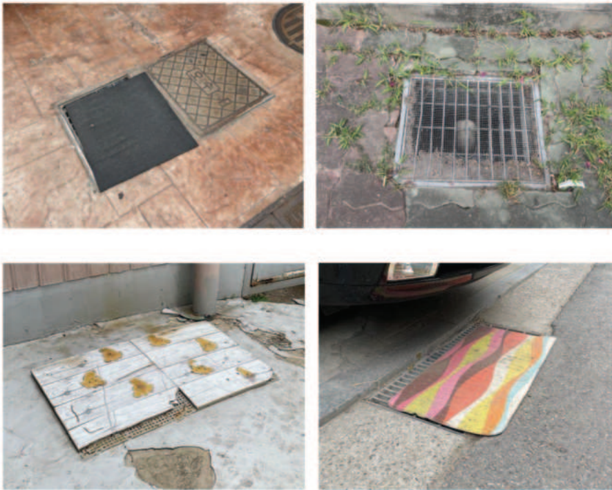
시민 임시방편 덮개 설치 (시공전)
