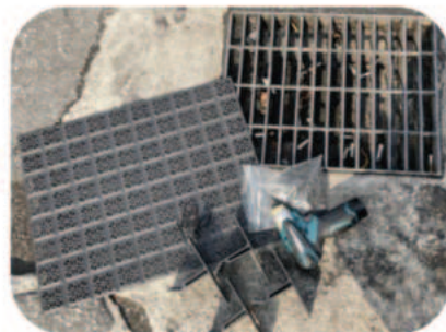
그레이팅 규격에 맞는 안전덮개, 소켓, 피스, 전동드릴을 준비한다
