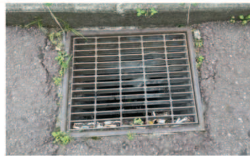
그레이팅 안전덮개 설치 예시
