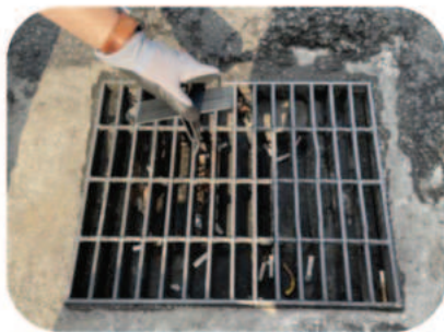
소켓 설치 위치를 계획하고 그레이팅 베어링바 하단부에 끼워 설치한다
