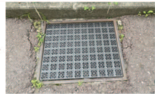
그레이팅 안전덮개 설치 예시
