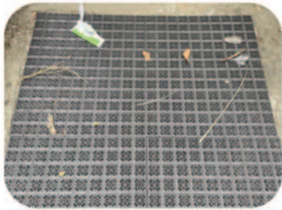
시공이 완료된 후 안전덮개 위로 낙엽 등의 쓰레기 유입 시 청소 한다
