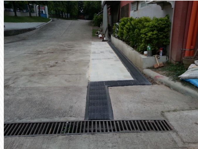
[필리핀 세부 과학기술청(DOST7)청사 시공현장]
