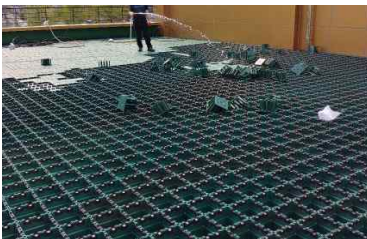
1. 빗물저금통 모듈 설치
