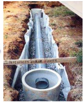
[침투통, 트렌치 설치]
