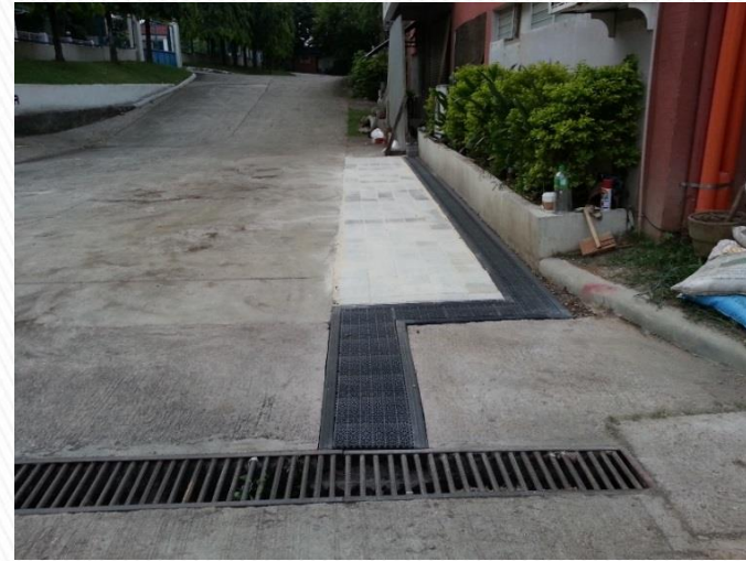
[필리핀 세부 과학기술청(DOST7)청사 시공현장]
