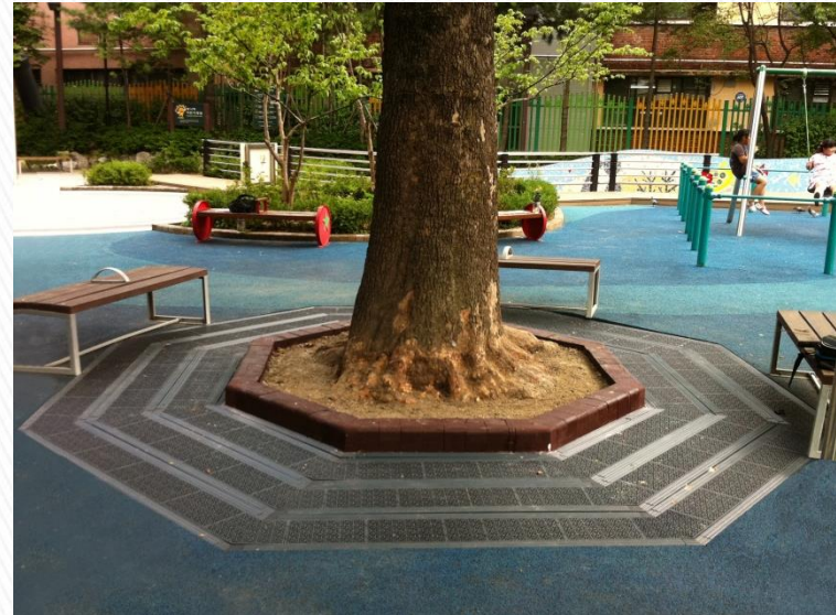
용산 새나라 어린이 공원 팔각보호판 시공 후
