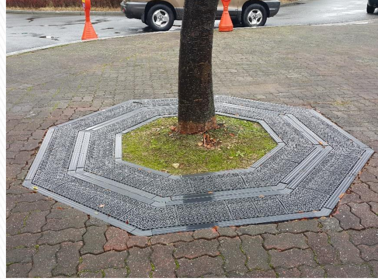
군산시청 팔각보호판 시공 후
