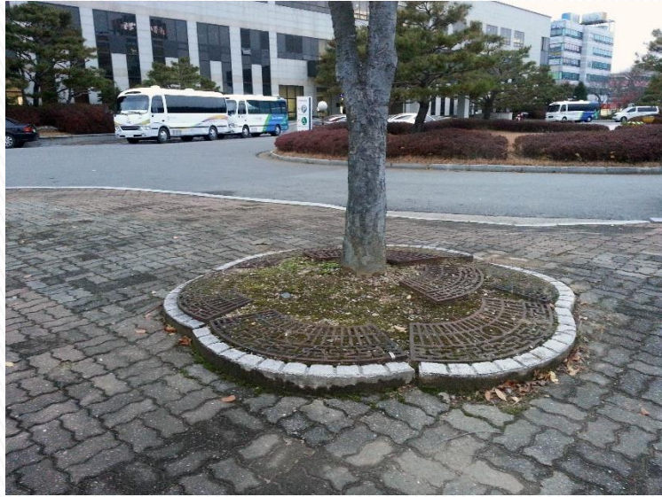
군산시청 시공 전
